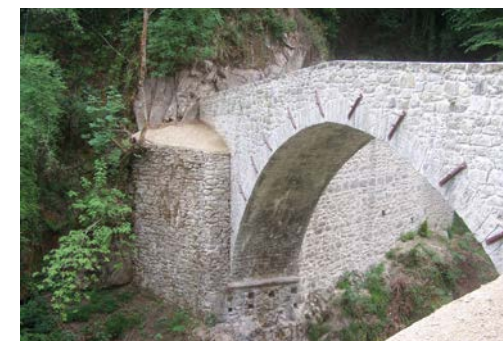
Il ponte dopo il restauro.
